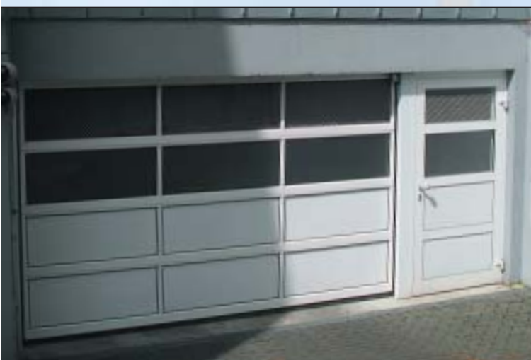
Sectionaltor SL mit Nebentür, ISO-Platten kombiniert mit Streckgitter in Tiefgarage.
